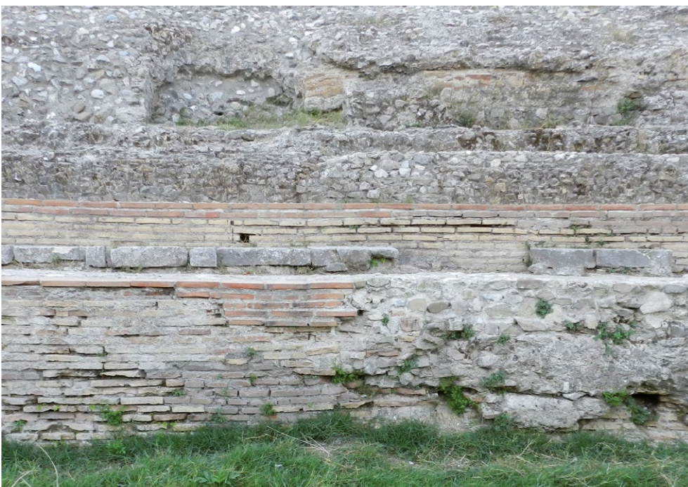
Abb. 42: Podiumsmauer im Westen bestehend aus Ziegeln und Opus Mixtum
