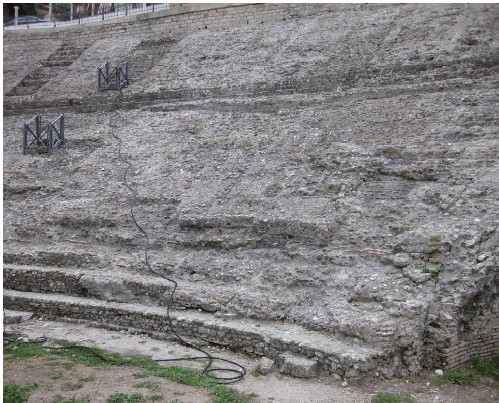
Abb. 58: Moderne Wiederherstellung des Unterbaus der Caveastufen, die den ursprünglichen Zustand verunklärt
