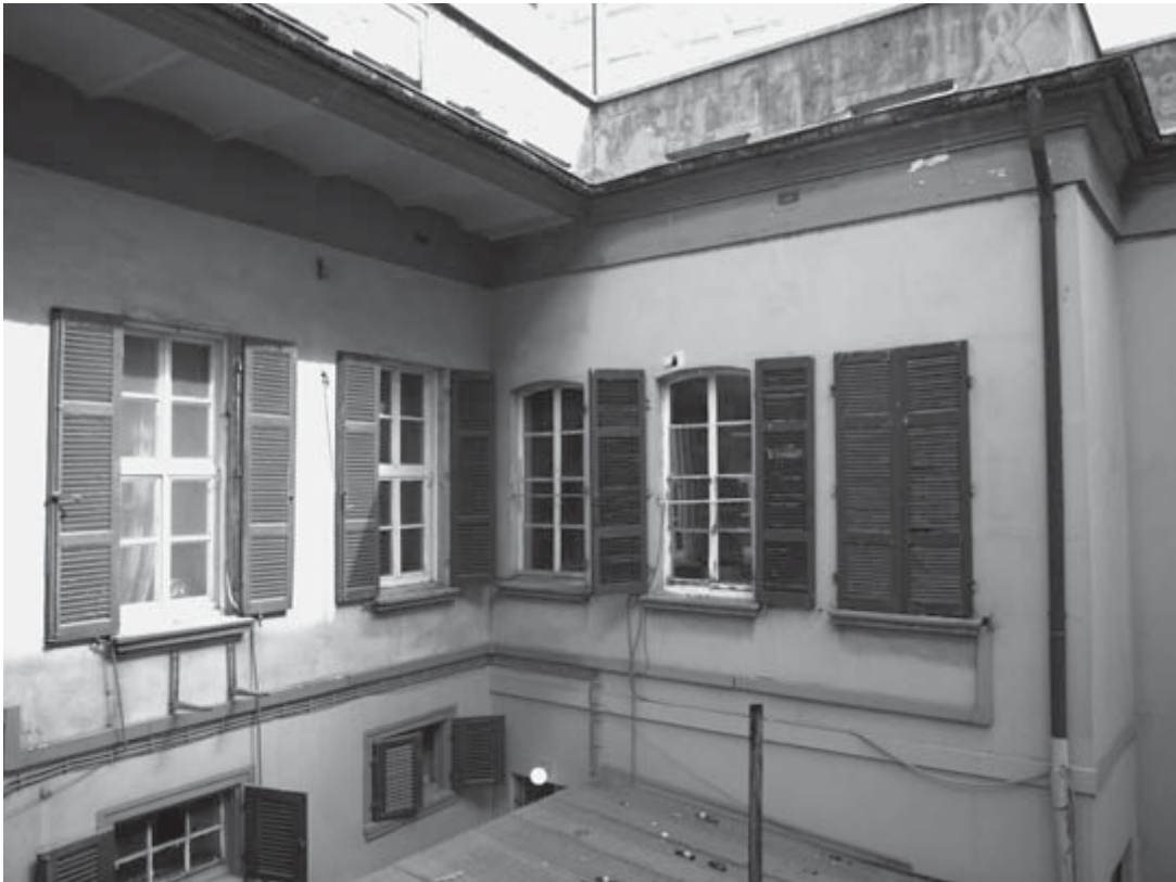
Abb. 17 Obergeschosszone der Seitengebäude im Hof mit den segmentbogenförmigen Fenstern im Rückgebäude, 2012
