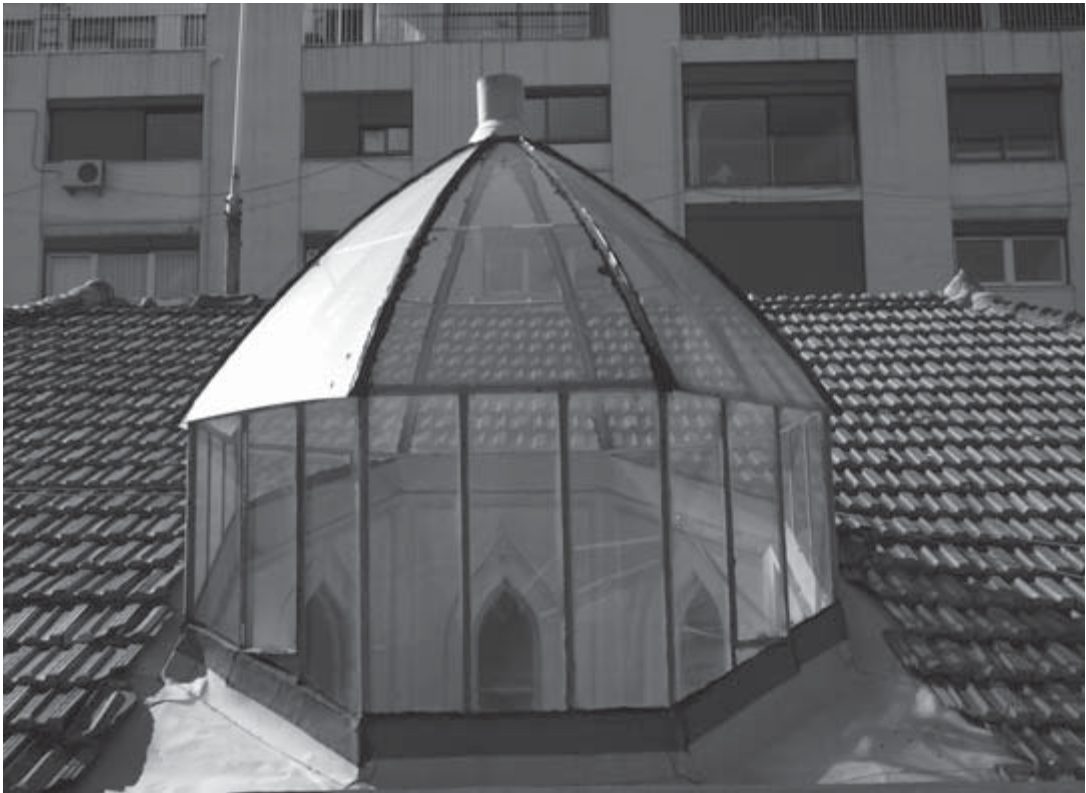
Abb. 12 Das baldachinartige Oberlicht über dem Treppenhaus des Palais Guiffroy, 2012
