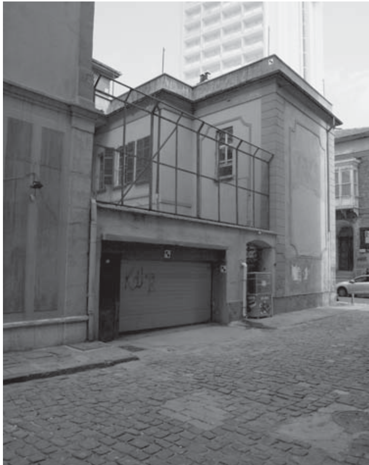
Abb. 18 Südlicher Abschnitt des Rückgebäudes mit dem aufgelegten Putzspiegel, 2012
