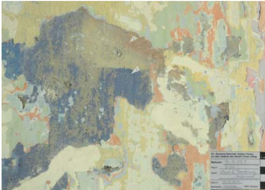
Abb. 42 Klassische Befund- situation 2010 mit blauer Erstfassung in Raum 0-07 (Erdgeschoss)
