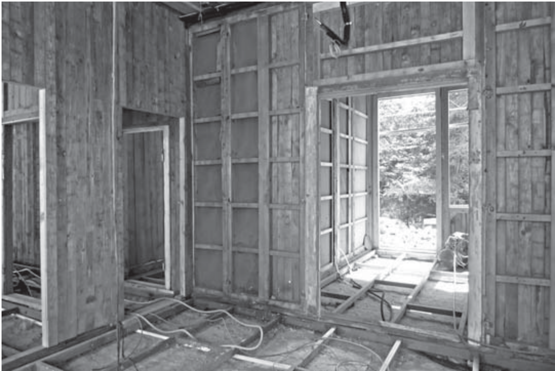
Abb. 31 Ankara, eh. Deutsche Botschaft, Bauarbeiten September 2014
