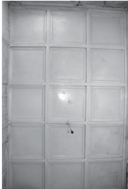
Abb. 35 Die Deckengestaltung in Raum 0-07 (Erdgeschoss) imitiert eine massive Holzbalkendecke
