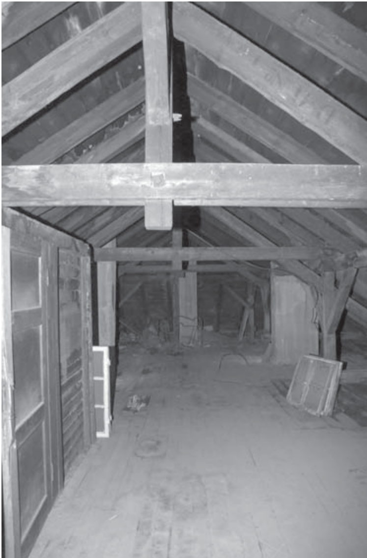
Abb. 37 Blick auf die Dachkonstruktion nach Westen in Raum D-01. Am rechten oberen Sparren ist die werkseitige Beschriftung erkennbar
