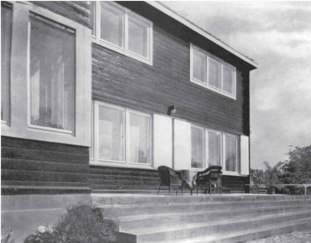
Abb. 18 Niesky, Direktorenwohnhaus, Gartenseite, Konrad Wachsmann 1927, Blockbauweise. Durch die Aufnahme Perspektive wirkt das Haus wie mit einem Flachdach ausgeführt.
