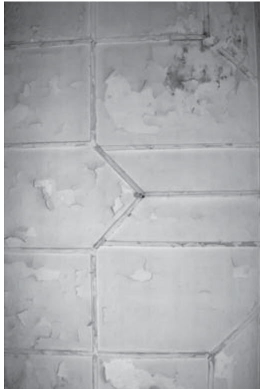
Abb. 36 Die Deckengestaltung in Raum 1-06 (Obergeschoss) zeigt eine vielseitige Gliederung in rechteckige und rhomboidale Felder durch flache Deckleisten
