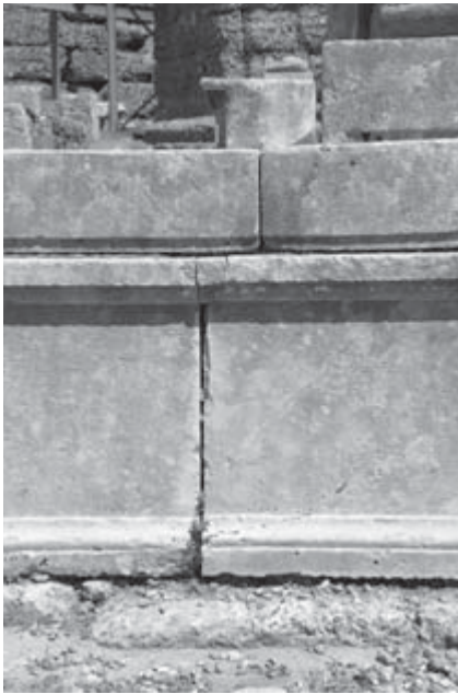
Abb. 3a. b Frühere Nordwestecke des Podiums von West (links) mit der Euthynterie, dem Sockel und der zweistufigen Krepis und die gleiche Ecke von Nord (rechts) mit dem zuvor auf der Schmalseite verbauten Krepisblock mit der Tropfspur des Stylobatblocks im Vordergrund. 2011
