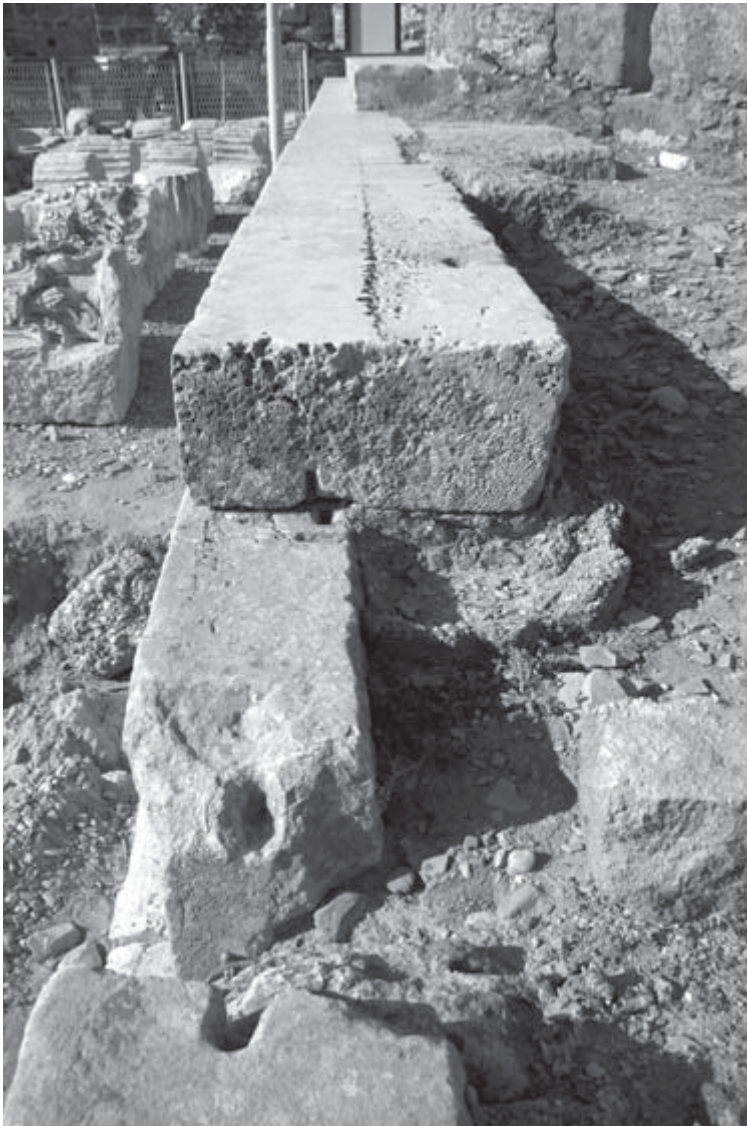
Abb. 5 Details der Podiums-konstruktion auf der Nordwestseite: im Vordergrund eine antike Reparatur einer gebrochenen Sockelplatte (sekundäre Verklammerung), darüber unterer Krepisblock, der mit einem Kantendübel mit der schmalen Sockelplatte verbunden ist. 2011
