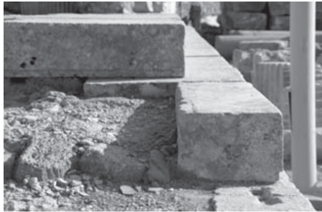
Abb. 3a. b Frühere Nordwestecke des Podiums von West (links) mit der Euthynterie, dem Sockel und der zweistufigen Krepis und die gleiche Ecke von Nord (rechts) mit dem zuvor auf der Schmalseite verbauten Krepisblock mit der Tropfspur des Stylobatblocks im Vordergrund. 2011
