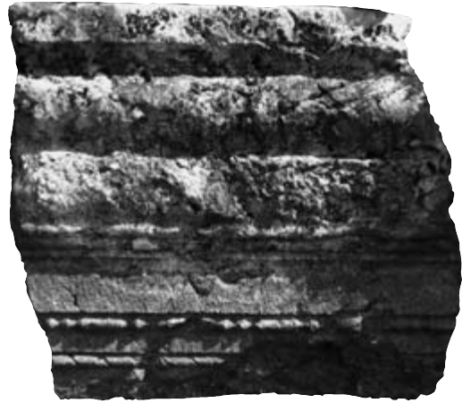
Abb. 32 K 17, sekundär zu Quader umgearbeiteter Architrav
