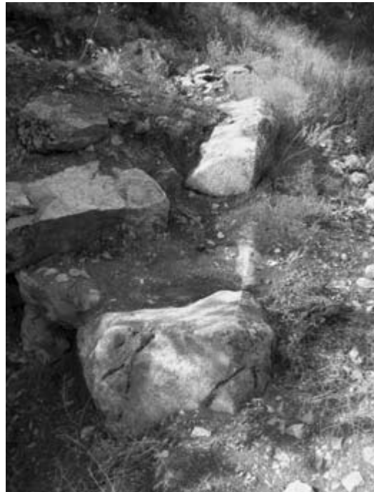
Abb. 27 Kante der Terrassenmauer neben dem Raubblock (von Süden)
