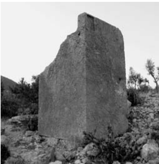
Abb. 8 Asarcık, Pfeilergrab und sein Stufendach von Nordosten
