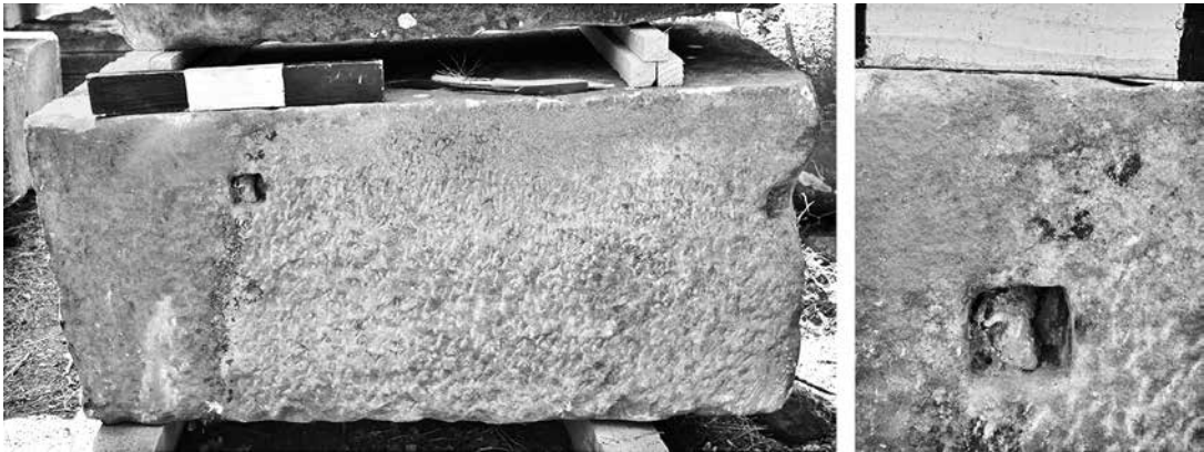
Abb. 12 Westwand-Quader der unteren Lage mit Bleiverguss und Aussparung für Metalldübel
