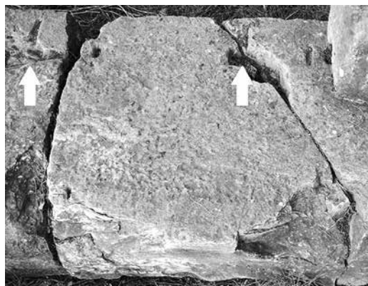
Abb. 13 Westwand, Toichobatblock mit benachbarten Dübellöchern mit Gusskanälen (Pfeile); hierhin wurde der zuletzt versetzte Quader der Außenschale gelegt
