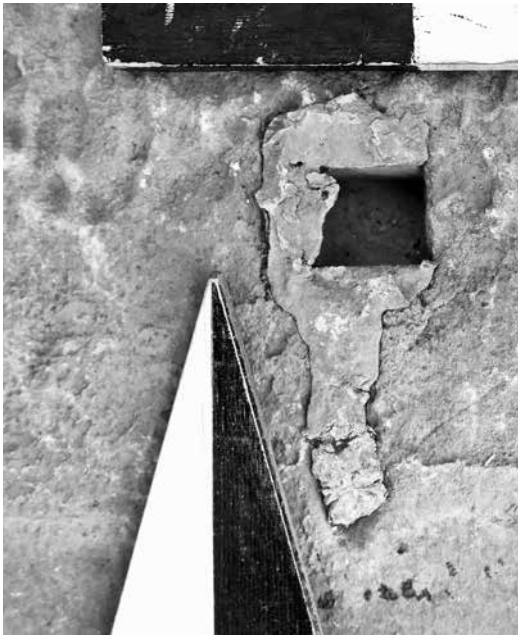
Abb. 14 Krepis der Heiligen Halle, Bleiverguss im Dübelloch und Gusskanal
