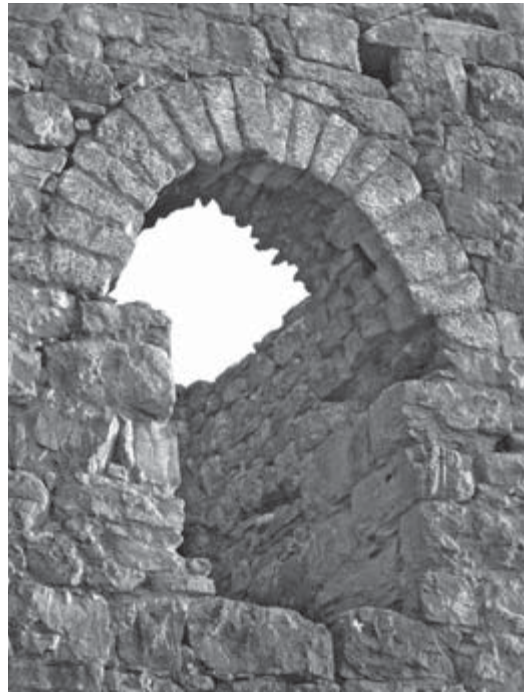
Abb. 9 Kirse Yanı, EG_02, N-Fenster, Außenansicht
