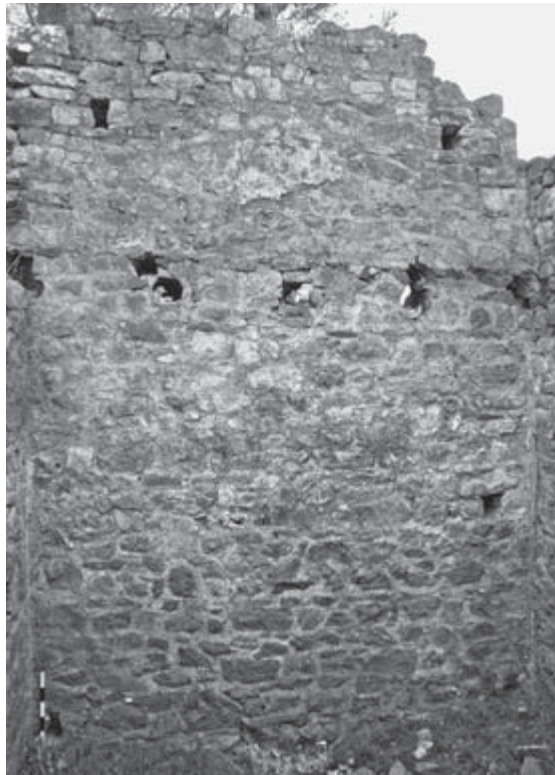
Abb. 11 Kirse Yanı, EG/OG_02, S-Wand von Norden
