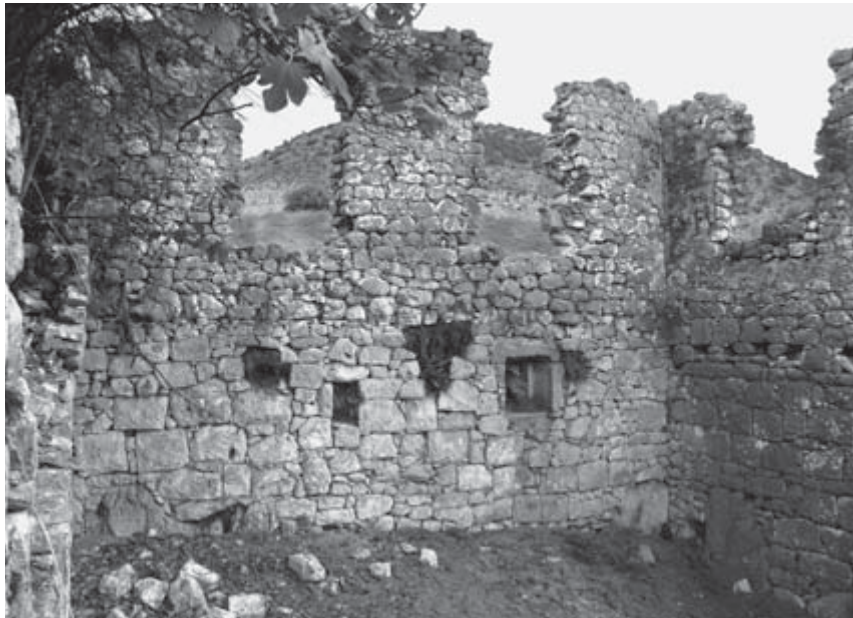
Abb. 44 An- driake, N-Stadt, frühbyzantinisches Haus, NO-Eck- raum, Innenan- sicht nach Norden
