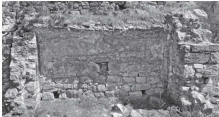
Abb. 22 Kirse Yani, EG_11-1, Südwand-Nische von Norden
