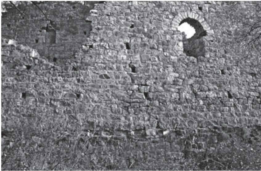
Abb. 8 Kirse Yanı, N-Wand mit Fenster zu EG_02 von Norden
