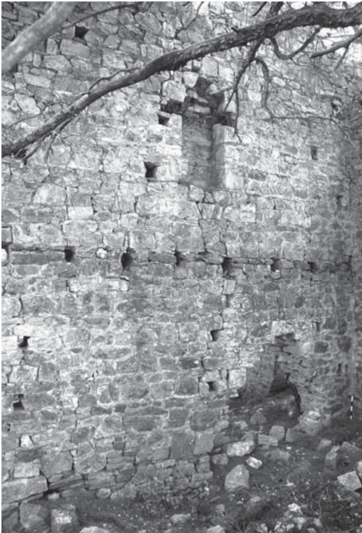
Abb. 12 Kirse Yanı, EG/ OG_07, S-Wand von Norden
