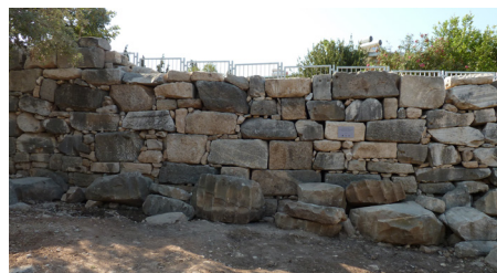
15 Tempelareal, ‚Mandramauer‘, Abschnitt 6 nach der Wiederherstellung. (Foto: H. Bumke)
