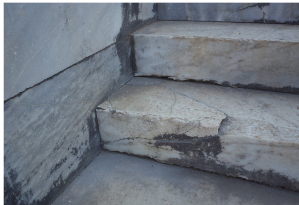
29 Apollontempel, Adyton, Freitreppe, nördl. Seite, 9. Stufenreihe. Wiederanbringung eines gelösten Stufenfragmentes. (Fotos: Ch. Kronewirth)
