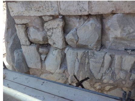
23 Apollontempel, Zweisäulensaal, Ostwand, südl. Abschnitt, Teilbereich während der Konsolidierung mit z. T. entfernten alten Zementmörtelergänzungen. (s. Abb. 22, roter Rahmen; Foto: Ch. Kronewirth)
