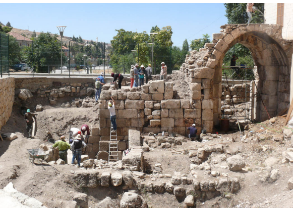
12 Reinigungsarbeiten am Damaskustor in Vorbereitung von Konservierungsmaßnahmen (Foto: J. Abdul Massih).
