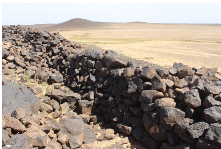
4 Blick auf einen Abschnitt der Befestigungsmauer am Südrand von Khirbet al-Ja'bariya (Foto: B. Müller-Neuhof).
