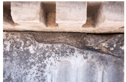
Abb. 55: Pergamon, Gymnasion. Rekonstruierte Säulenstellung in der Nordwestecke der Palästra, mit Mörtel verschlossener Ausbruch unterhalb des Zahnschnitts
