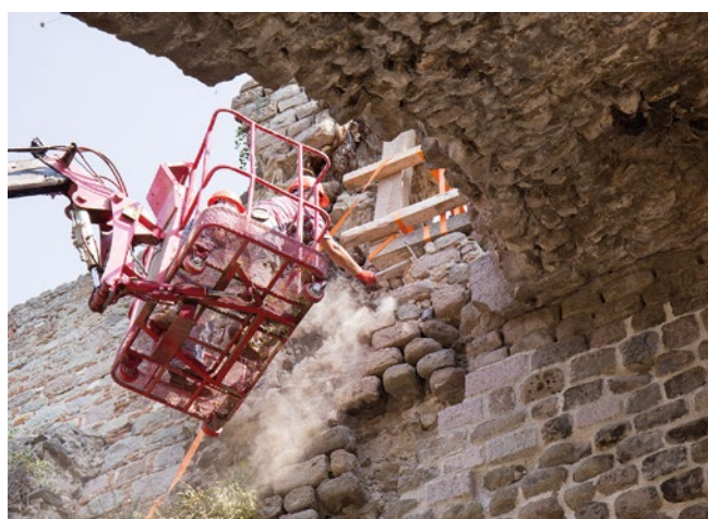
Abb. 63: Pergamon, Rote Halle. Entfernung losen Mauerwerks an der südöstlichen Temenosmauer unter Nutzung eines Steigers
