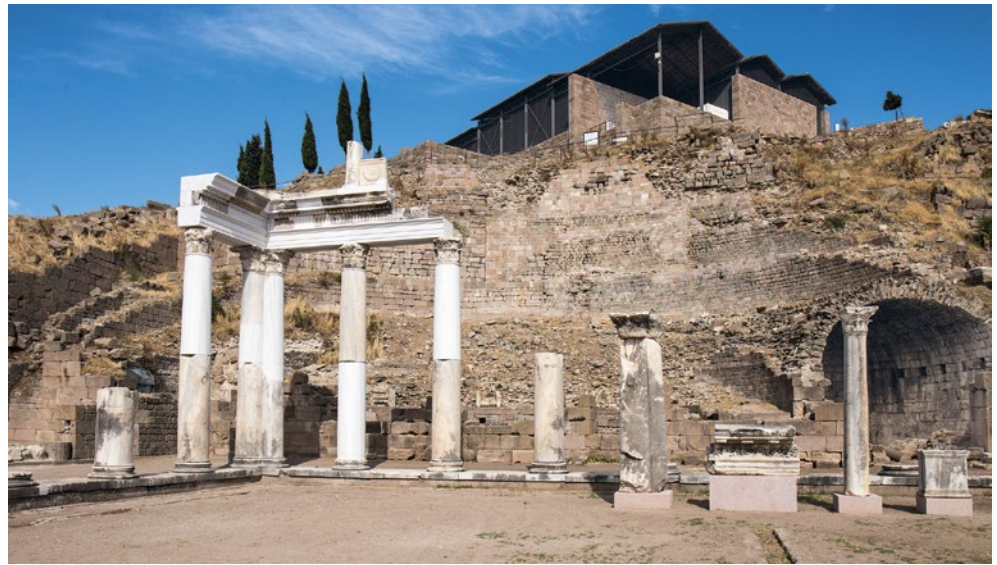
Abb. 54: Pergamon, Gymnasion. Rekonstruierte Säulenstellung in der Nordwestecke der Palästra, Auffüllen von Rissen mit acrylharzbasiertem Mörtel
