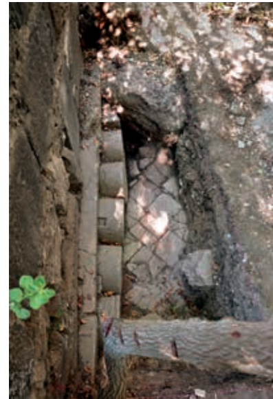
Abb. 12 Milet, Humeitepe. Schräge Aufsicht auf die »Gotenmauer«
