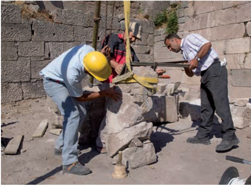
Abb. 71 Pergamon, Gymnasion. Parodostor, die in zahlreiche Fragmente zerbrochenen Keilsteine des Bogens wurden aufwendig restauriert, um die Werksteine wieder in die Konstruktion einsetzen zu können
