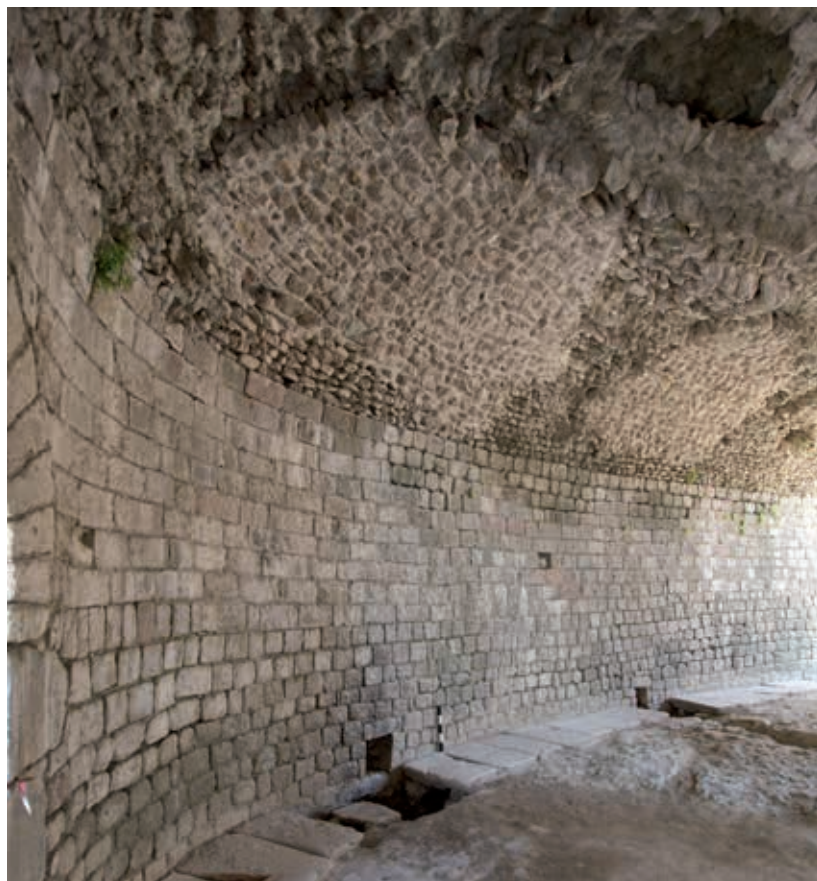
Abb. 85 Pergamon, Asklepieion. Retuschierte Ergänzungen der römischen Ringtonne im Unteren Rundbau
