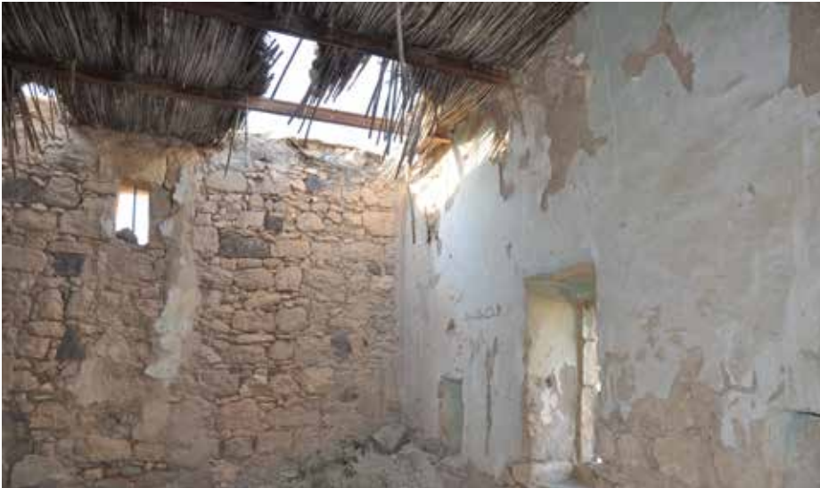
12 Blick ins Innere des Hauses auf die noch vorhandene Dachkonstruktion. Sichtbar sind die in die Außenwände eingelassenen Metallschienen und kreuzweise darauf eine Schicht aus Bambusstängeln. Darüber liegt eine Schicht von Oleanderästen und Stängeln des Gefleckten Schierlings. Darauf liegt eine dichte Isolationsschicht aus Getreidestroh, überwiegend aus Hartweizen, und darauf folgt abschließend ein Lehm Dachpflaster (Foto: R. Neef).
