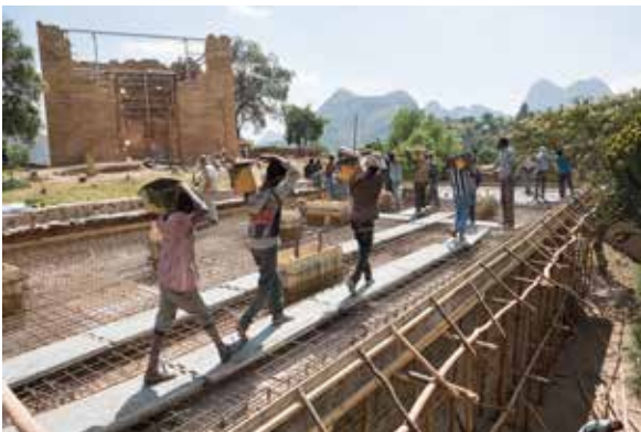
6 Yeha (Äthiopien). Bau des Museums von Yeha: Errichtung der Stahlbetondecke (Foto: I. Wagner).
