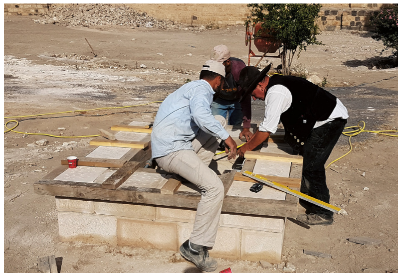
48 Alhara Alfoqa/Umm Qays (Jordanien). Bauwerkserhaltung als Trainingsprogramm, Werkhof (Bait Hussein Al Rousan): Versatz der bearbeiteten Blöcke für die Zisterneneinfassung. Foto: Olga Zenker, DAI Orient
