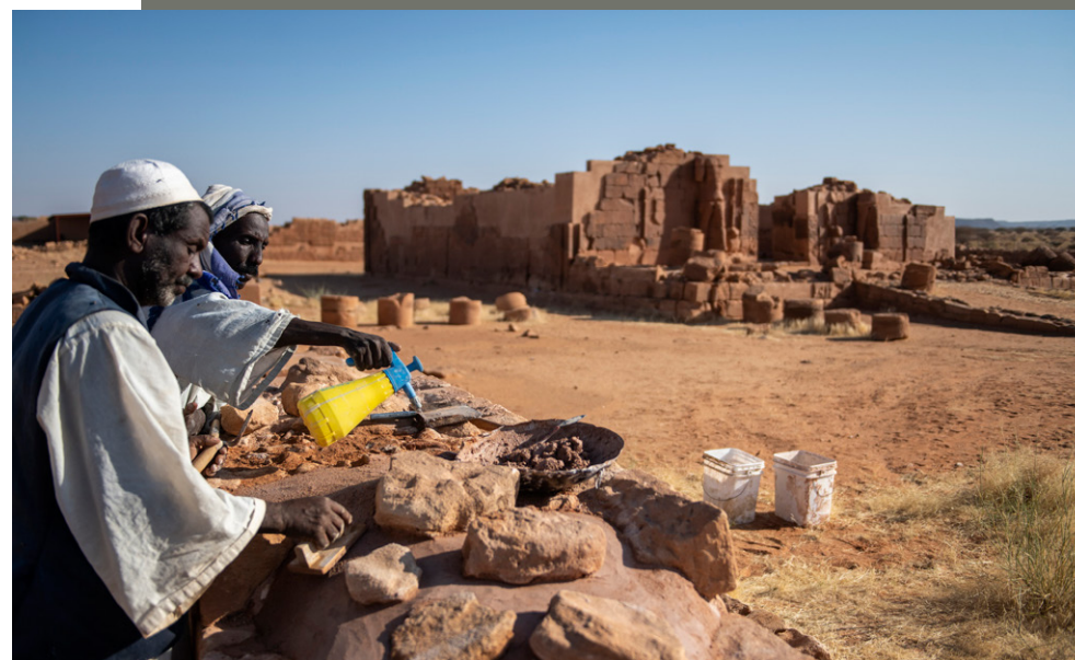
7 Lokales Team um Ahmed Musa bei schützender Abdeckung von Mauerkronen in der Großen Anlage von Musawwarat. Foto: Alvaro Minguito, DAI
