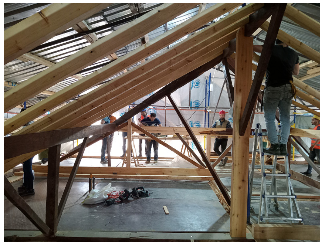
21 (links) Der historische Dachstuhl wird restauriert. Noch tragfähige Bestandhölzer bleiben erhalten und werden durch neue Balken ergänzt. Foto: Nathalie Chahine
