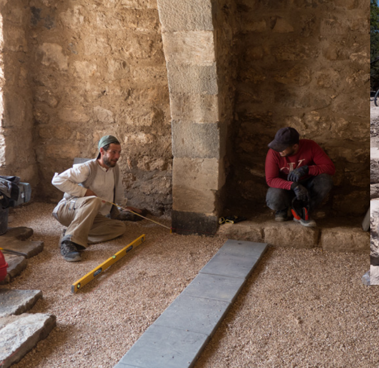
8 (links) Hara Foqa/Umm Qays (Jordanien). Bauwerkserhaltung als Trainingsprogramm. Maßnahmen beim Versetzen der Fußbodenplatten in der Madafeh. Foto: Claudia Bührig, Projekt Gadara/Hara Foqa DAI
