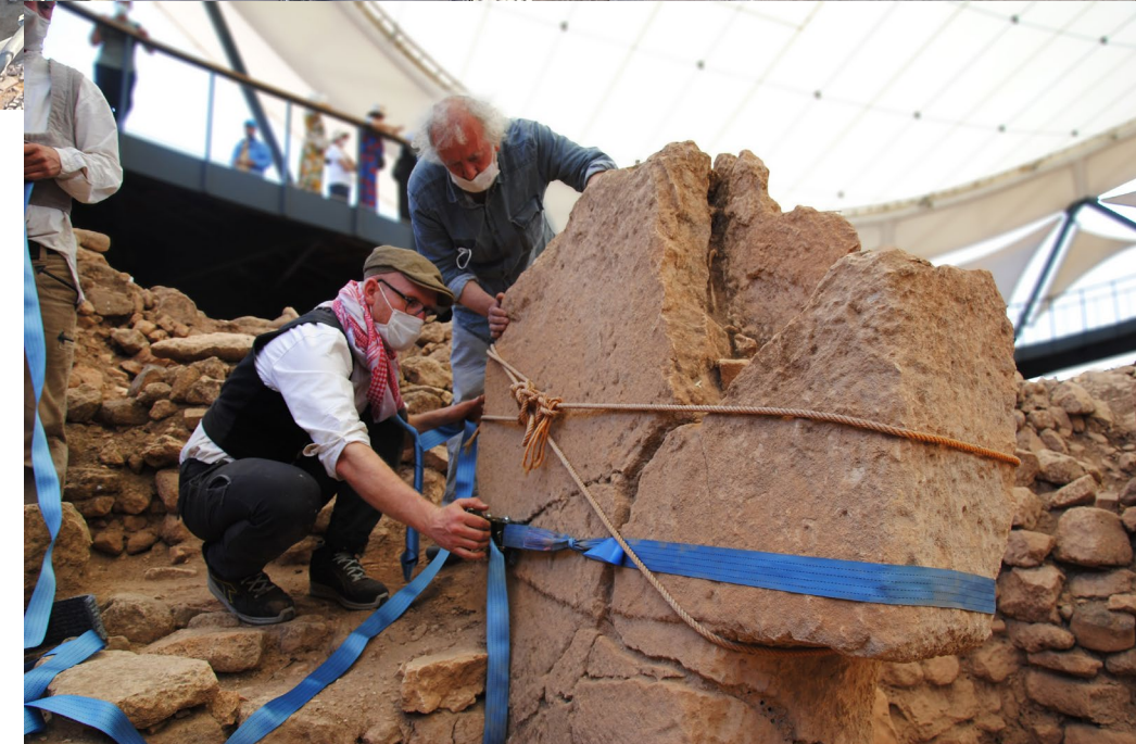
4 (oben) Didyma, Apollontempel, Einführung von Edelstahldübeln in Säule D9. Foto: Duygu Göcmen, DAI Istanbul/Didyma-Grabung
