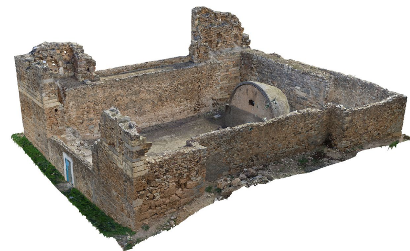
10 3D-Modell der Festung von Jougar (Gouvernerat Zaghuan, südlich von Karthago) aus Laserscan und UAV-Be-fliegung. Foto: Federico Caprioli, DAI Rom, INP Tunis
