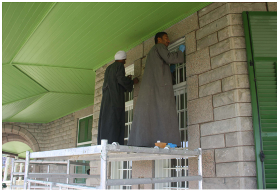
6b Reinigungsarbeiten am Natursteinmauerwerk des historischen Museums auf Elephantine. (Foto: M. Sählhof/DAI)
