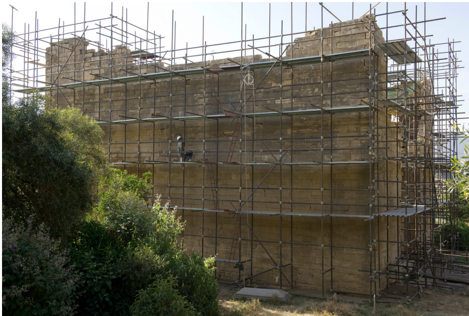
4 Almaqah-Tempel von Yeha (Äthiopien). Das Mauerwerk ist zur Zeit für die Durchführung von Konservierungsarbeiten vollständig eingerüstet (Foto: I. Wagner, DAI Orient-Abteilung).
