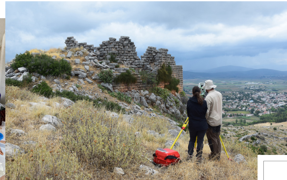
4 (links) Orchomenos (Böotien). Tachymetrische Vermessungsarbeit für die Bauaufnahme an der hellenistischen Akropolis-Festung. Foto: Eric Laufer, DAI
