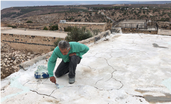
26 Gadara/Umm Qays, Jordanien. Bait Roussan (geplanter Werkhof), Nordflügel 2020. Verschließen der Haarrisse in der Dachfläche. (UQ HaFo 2020, Foto: A. al-Omari)
