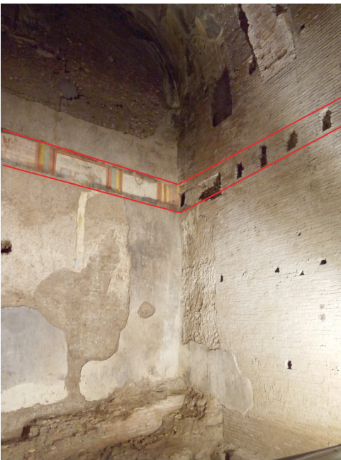
16 Südwand des Raumes 54 in der Domus Aurea mit erhaltener Malerei im Bereich des Zwischenbodens. (Foto: H.-J. Beste/DAI)
