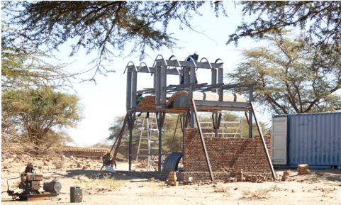
12 Meroe Royal Baths, Testbau im Rahmen der Schutzbau-Planung: Montage der Träger für die Dachabdeckung, darunter die Tonnengewölbe, das vorere noch über Lehrgerüst. Ausführung einer Musterfassade in zwei unterschiedlichen Brandziegelverbänden. (Foto: J. Herraiz Martinez/Kéré Architecture, 20200222_DG-2908_JH)
