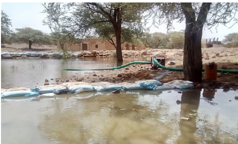
14 Meroe Royal Baths, Nilhochwasser im Herbst 2020: Doppelte Sandsackbarriere und Abpumpen des Wassers mit Motorpumpe. (Foto: O. Hasbelsoul/NCAM, 20200909_DG-0002_OH)
