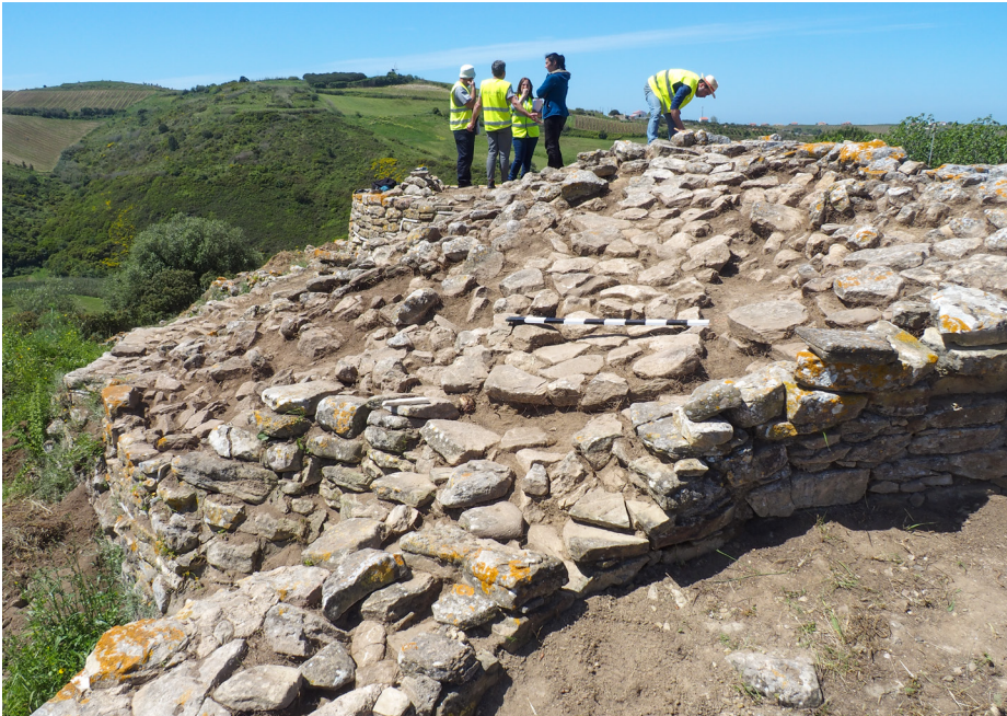
5 Zambujal. Ca. 1 m breites Steinpflaster zwischen den Türmen B (im Vordergrund) und G (im Hintergrund). Es deutet vermutlich die ehemalige Höhe der Befestigungsanlage in Phase 3 an, die später jedoch nochmal erhöht wurde. (Foto: D-DAI-MAD-MK-DG-038-2018-025)
