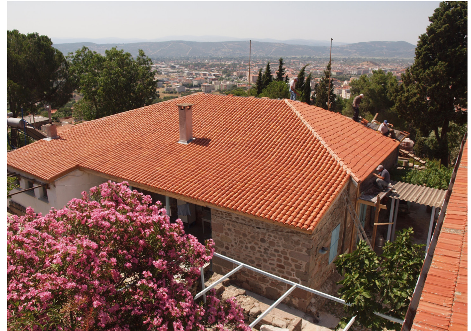
19 Das neugedeckte Dach der Grabungshauses in Pergamon (Foto: DAI Istanbul).
