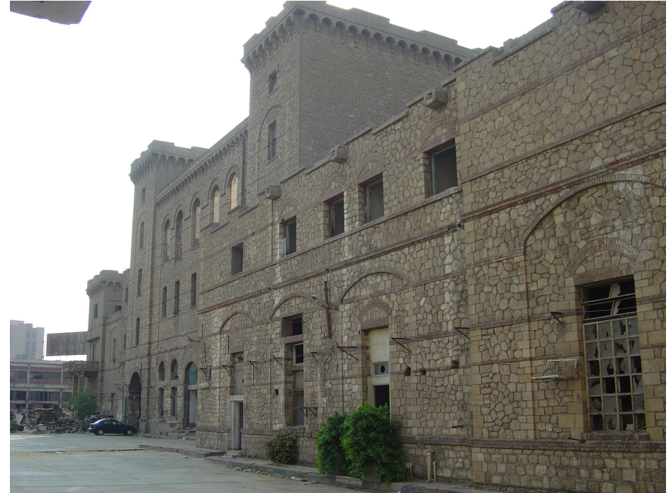
8 Giza. Die alte al-Ahram-Brauerei mit turmflankiertem Sudhaus (Foto: R. Bodenstern, DAI Kairo).
