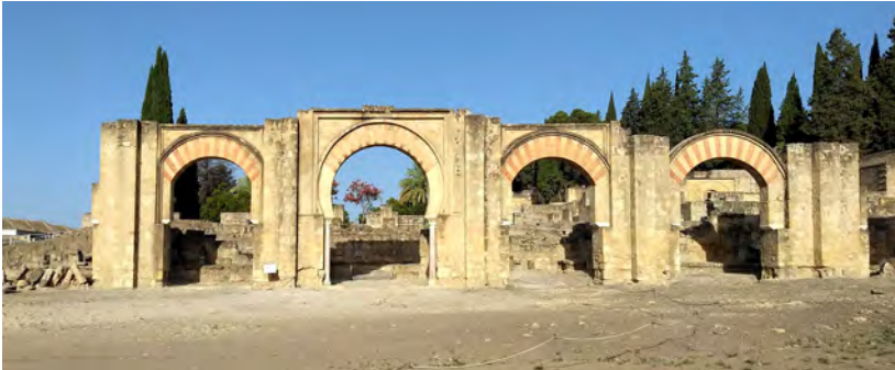
Abb. 5: Die wiederaufgebaute Portikus der Palastfassade
