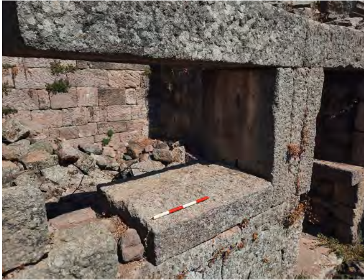
Abb. 7: Aigai, Marktbau. Raumachse 11, verstürztes Fenstergewände (F.11.B) vor der Konsolidierung
