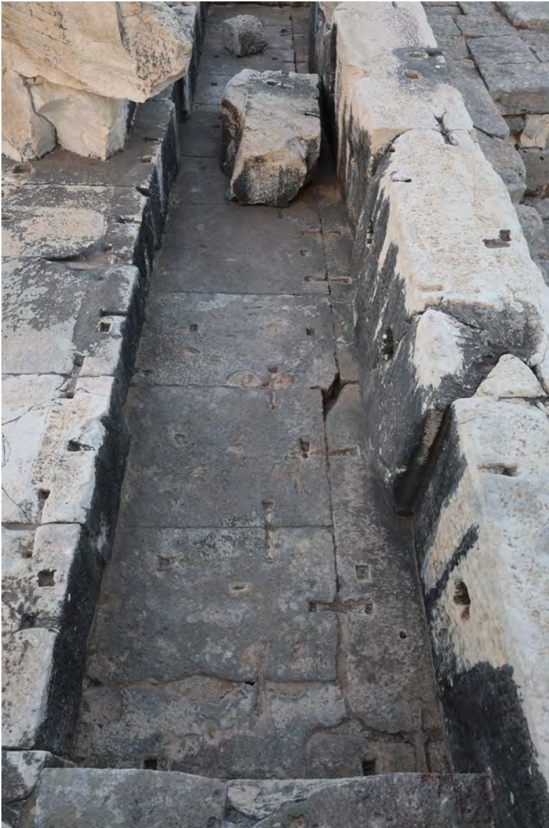
7 Unveränderte Mauerkrone der nördlichen Adytonmauer mit zahlreichen bautechnischen Befunden wie Klammer-, Dübel- und Stemmlöchern. (Foto: Konstantin Wächter)
