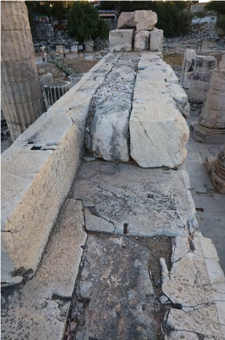
9 Nördliche Pronaosmauer. Im Vordergrund der einzige im Bestand eindeutig erhaltene Binder, der im Norden (im Bild links) teilweise von der 7. Steinlage verdeckt wird. (Foto: Konstantin Wächter)
