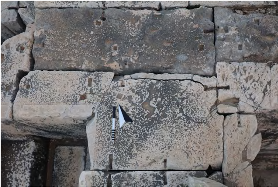
10 Nördliches Treppenhaus mit zwei Wandschalen abdeckendem Block im Nordosten des ersten Treppenpodestes. Zum Dodekastylos (Zwölfsäulensaal, im Bild rechts) wird nur ein Quader der schmalen Mauerschale ausgebildet. (Foto: Konstantin Wächter)
