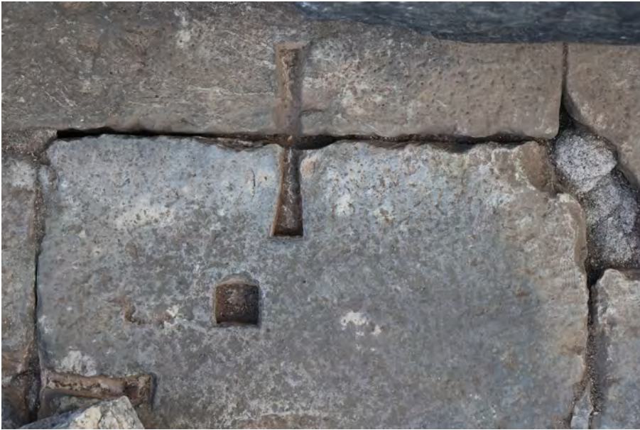
8 Blöcke der Kalksteinschale an der Nordwestecke des Apollontempels mit ungenutzten Klammerlöchern. Ausgearbeitet ist lediglich die schwalbenschwanzförmige Bleibettung, nicht jedoch die Einbindung des Klammerschenkels. (Foto: Konstantin Wächter)
