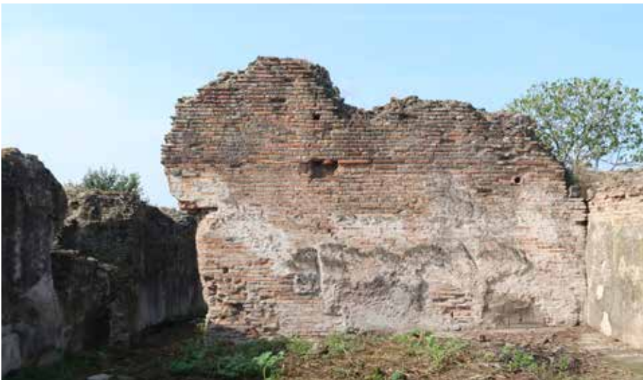
6 Zisterne Süd, Zwischenwand aus Osten mit Überlaufrohr aus Ton (o.r.) und Konturen der Treppenstufen. (Foto: I. Seiler)
