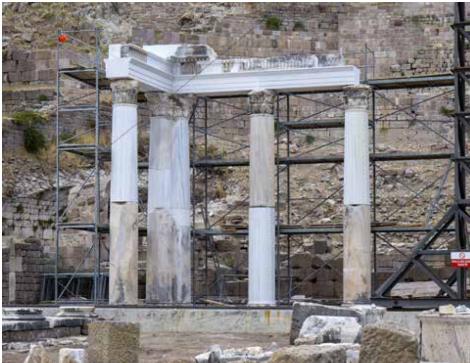
19 Pergamon, Stadtberg. Gymnasion. Anastylose der nordwestlichen Ecke der Säulenstellung in der Palæstra. Arbeitsstand am Ende der Kampagne 2017. (Foto: U. Mania)
