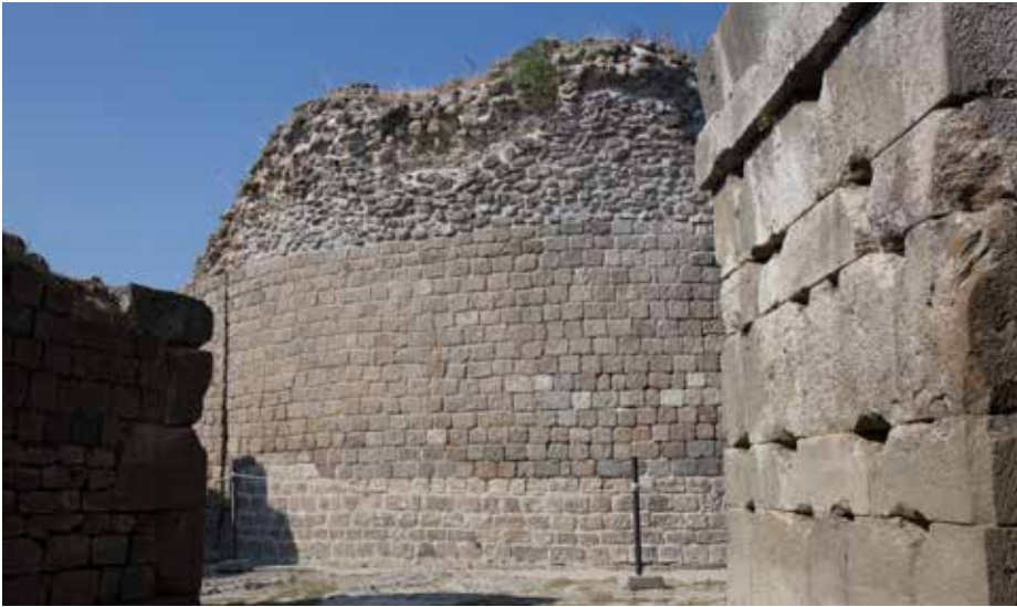
22 Pergamon, Asklepieion. Unterer Rundbau. Konsolidierung des Mittelpfeilers. (Foto: U. Mania)
