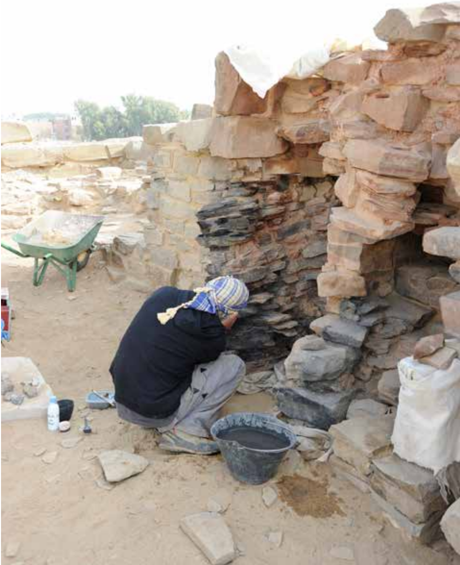
2 Konservierung am Mauerwerk der Brennkammer des Ofens im Gebäude E-b1. (Foto: K. Kuntz)
