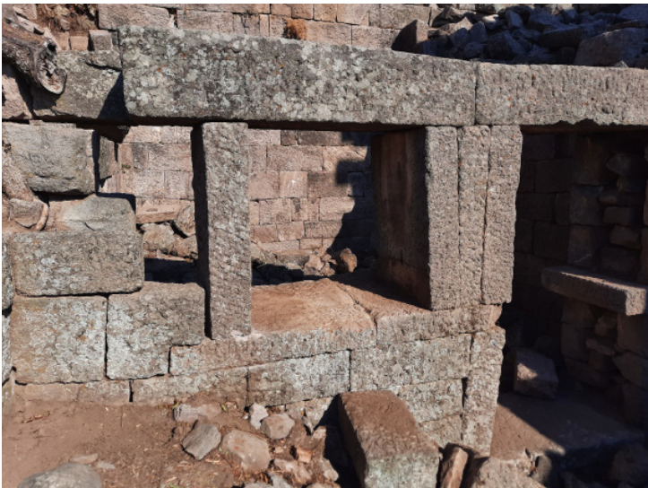
Abb. 8: Aigai, Marktbau. Raumachse 11, wiederaufgerichtetes Fenstergewände (F.11.B) nach der Konsolidierung
