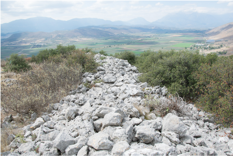
9 Orchomenos, Griechenland. Sperrmauer aus Bruchsteinwerk auf dem Bergrücken nordwestlich des Kastells. (Foto: D-DAI-ATH-Archiv-GA-ORC-DF-2021-00771, Eric Laufer)
