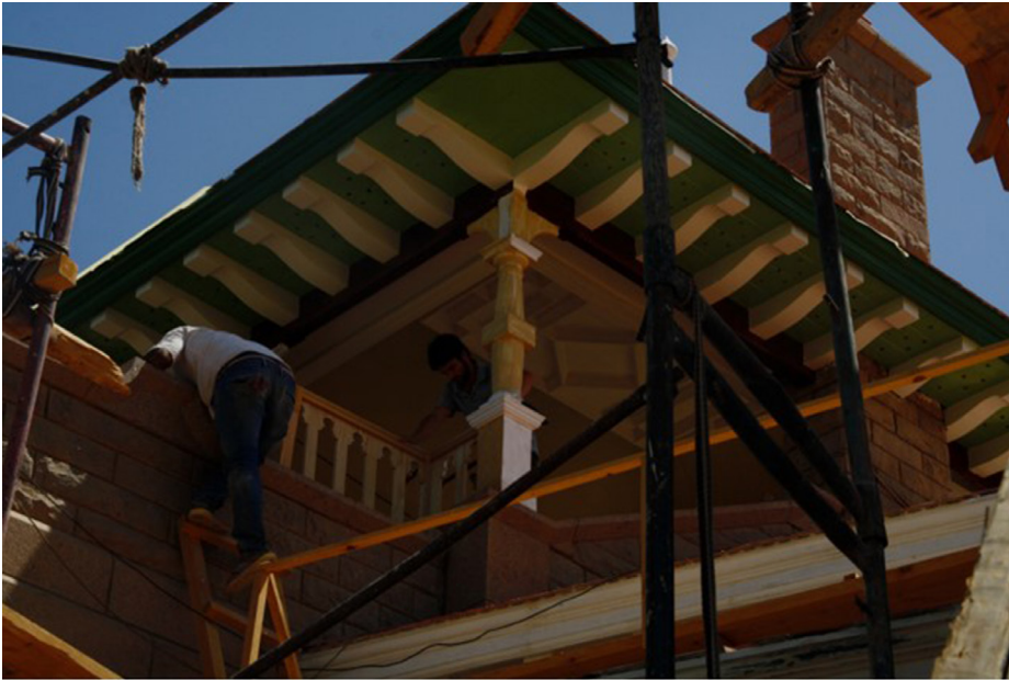
10 Schreinerarbeiten und Neuanstrich im Pavillon auf dem Dach des Aswan Museums auf Elephantine, Juni 2019. (Foto: M. Sählhof, DAI Kairo)
