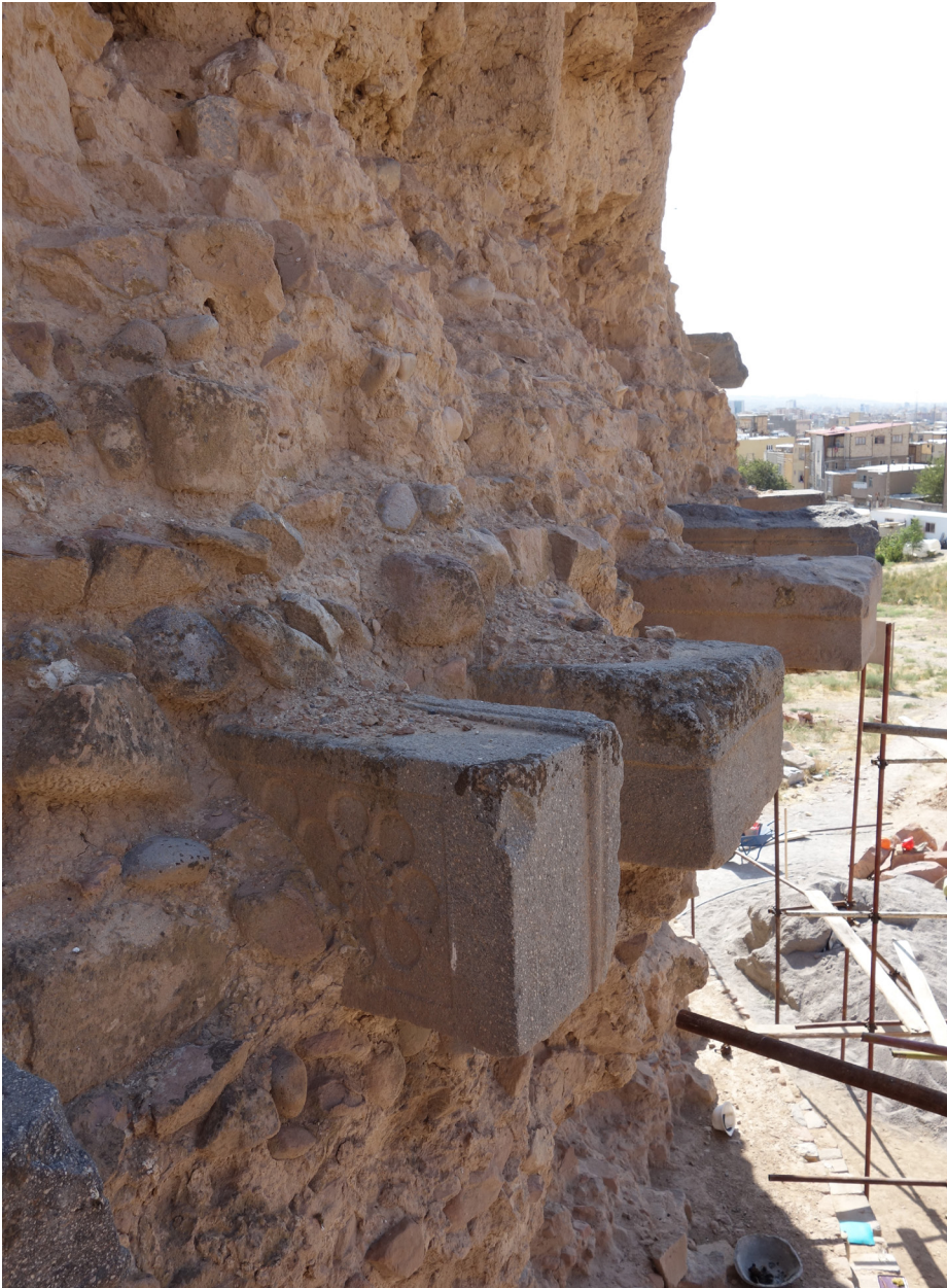
3 Grabsteine aus Basalt im Mauerwerk der Bastion (Foto: C. Fuchs).
