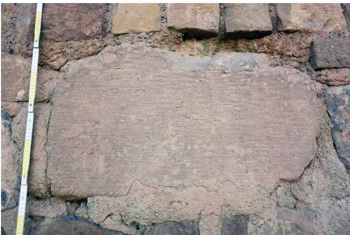
5 Wiederverwendeter, ilkhanidischer Buntsandsteinblock auf der Südseite der Bastion. Die Oberfläche ist leicht gekrümmt, weist eine Scharrierung und ein Steinmetzzeichen auf (Foto: C. Fuchs).
