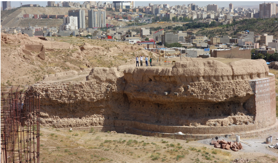
2 Gesamtansicht der Südbastion von Westen (Foto: C. Fuchs).
