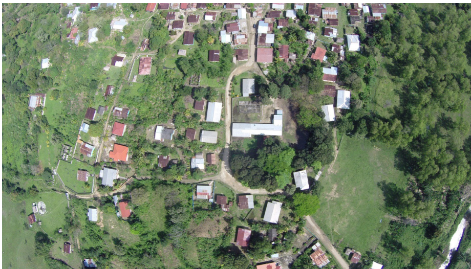
2 Luftbild des Dorfes Guadalupe mit dem Schulgelände und dem Grabungsplatz in der Bildmitte. Der Grabungsplatz befindet sich unter den großen Bäumen unterhalb des Schulgebäudes (Foto: M. Reindel).
