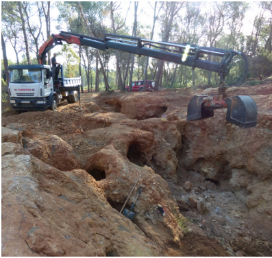
4a. b Arbeiten mit dem LKW-Kran und Greifbagger im Tagebau im Bereich C4-16 (Fotos: M. H. Hermanns).
