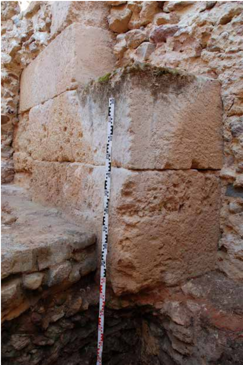
5 Gebäude I, Nordostecke über frühpunischem Raum T/2, El-Haouaira-Blöcken auf rotem Bettungslehm (Foto: Ch. Flügel, München).
