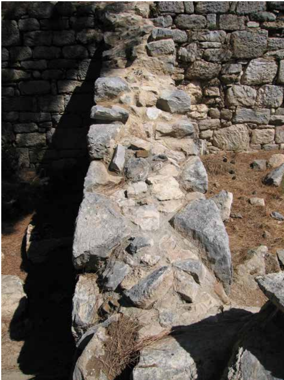
3 Beispiel der Mauerkronenkonsolidierung im Westviertel (Foto: A. Filges, Universität Frankfurt).
