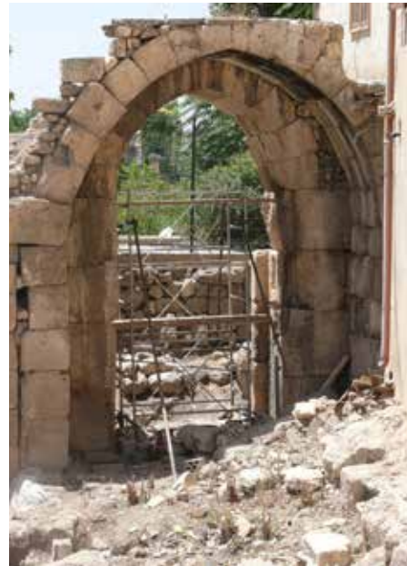
9 „Bustan Nassif“, Konsolidierungsarbeiten zum Erhalt des mittelalterlichen Stadttors (Foto: J. Nádor).
