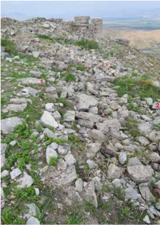
25 Die weitgehend zerstörte Raumfolge im Osten der Anlage von Süden gesehen. Nr. 1: Terrassierungsmauer, Nr. 2: flaschenförmige Zisterne Ci3 (Foto: M. Jonasch).
