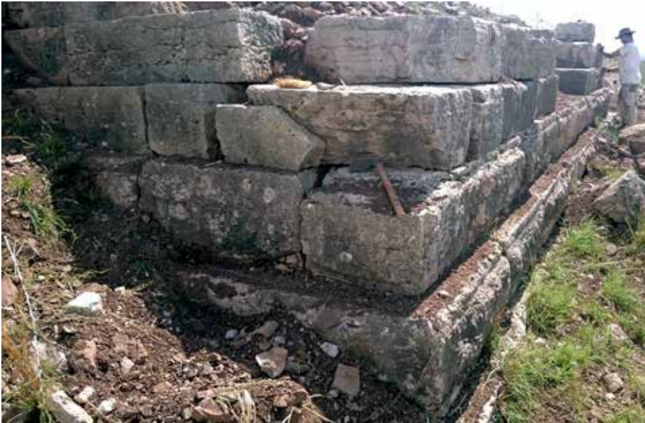
5 Oberflächliche Reinigungsarbeiten am Vorwerk des Westhangs (Foto: M. Jonasch).
