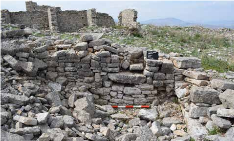
21 Gebäude im Südost-Quartier der Festung mit hoch anstehendem Mauerwerk aus Bruch- und Hausteinen und Maueröffnung (Foto: M. Jonasch).
