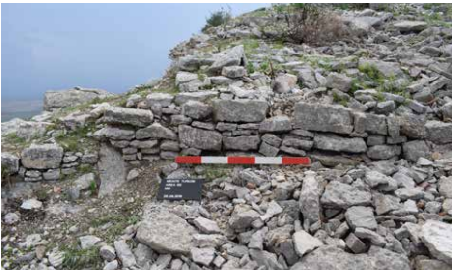
22 Eine von mehreren Mauern aus Bruch- und Hausteinen auf dem ansteigenden Fels im Südosten der Festung (Foto: M. Jonasch).
