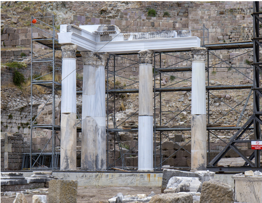
19 Pergamon, Stadtberg. Gymnasion. Anastylose der nordwestlichen Ecke der Säulenstellung in der Palästra. Arbeitsstand am Ende der Kampagne 2017. (Foto: U. Mania)
