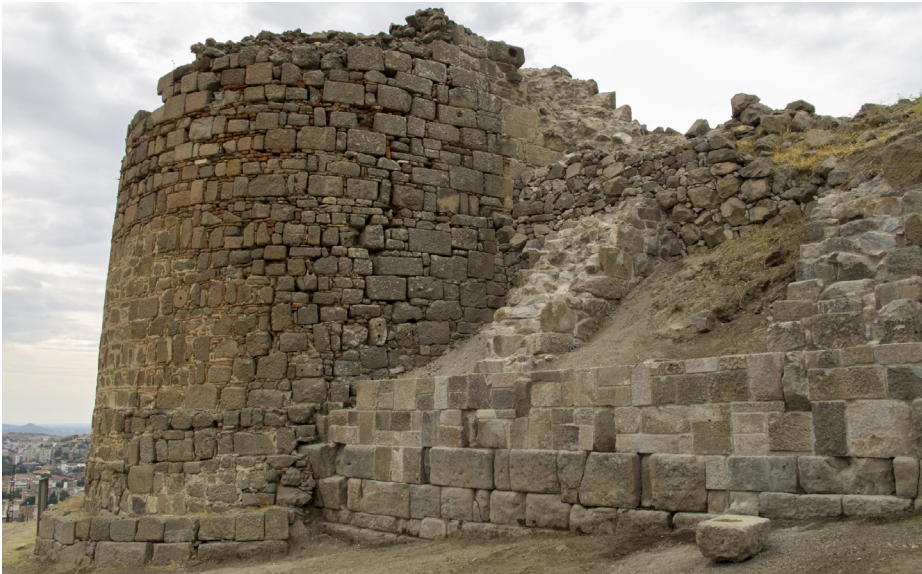
20 Pergamon, Stadtberg. Gymnasion. Mittlere Terrasse. Konsolidierung des Übergangs zwischen hellenistischer Terrassenmauer und spätbyzantinischer Befestigung. (Foto: S. Tezer-Altay)
