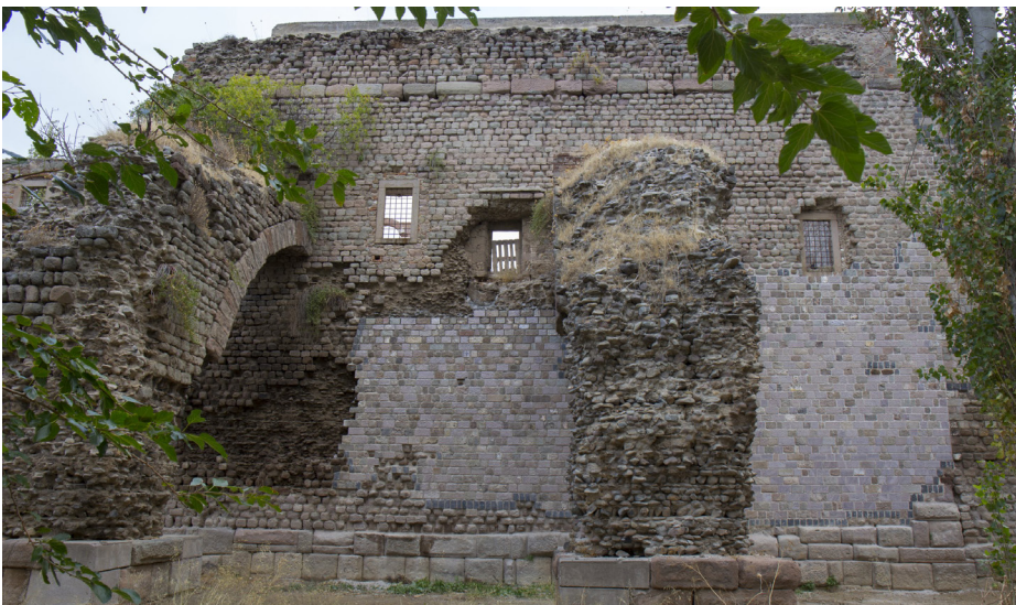
21 Pergamon, Unterstadt. Rote Halle. Ansicht der südlichen Temenosmauer nach Abschluss der Arbeiten 2017. (Foto: U. Mania)
