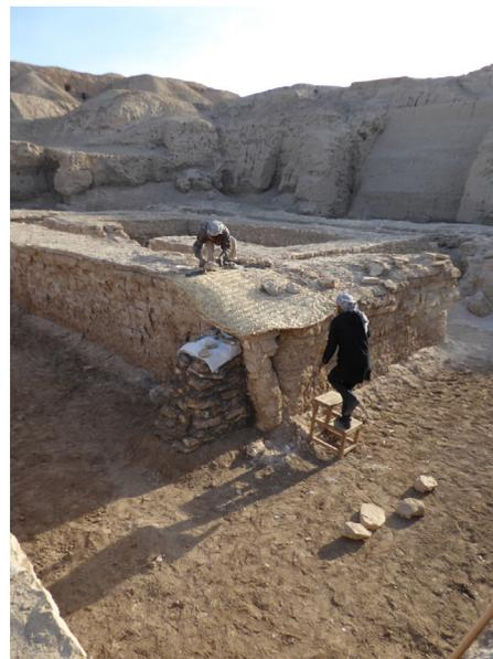
10 Steingebäude in Uruk, mittleres Mauerrechteck. Provisorische Abstützung eines ausbrechenden Teils der Kunststeinmauer (Foto: M. van Ess).
