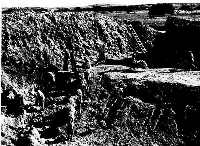
2. Der Nordost-Teil der Belagerungsrampe während der Abtragung (1955). Am linken Bildrand Reste des Schwellbrandes über dem Ende von Stollen 1; rechts die feldseitige Böschung des Wehrgrabens
