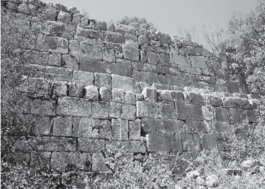
Abb. 2: Östliche Stadtmauer von Kyaneai
