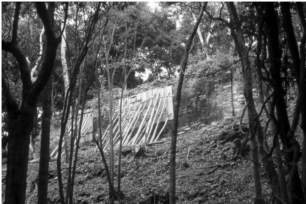
Fig. 23. Naranjo, Acrópolis Oeste; apuntalamientos de muros en peligro de derrumbarse (foto: R. Noriega).
