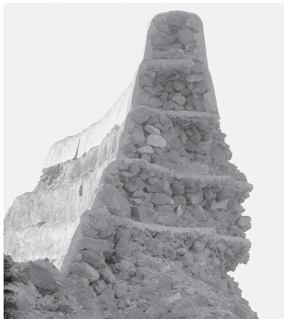
Abb. 25. Marib, Wadi Gufayna, angeschnittene Schüttmauer des Dammes.
