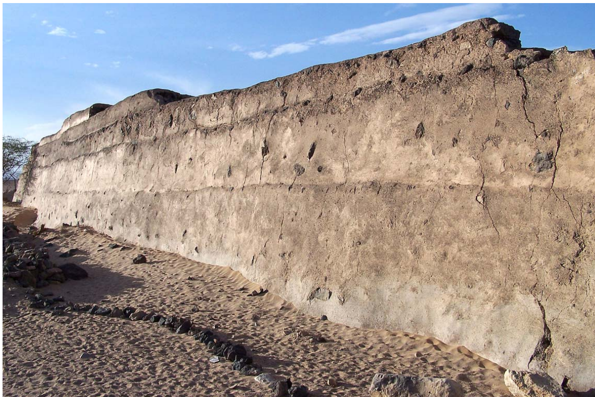
Abb. 26. Marib, Wadi Gufayna, Schüttmauer-Dammanlage (Foto: J. Laxman).
