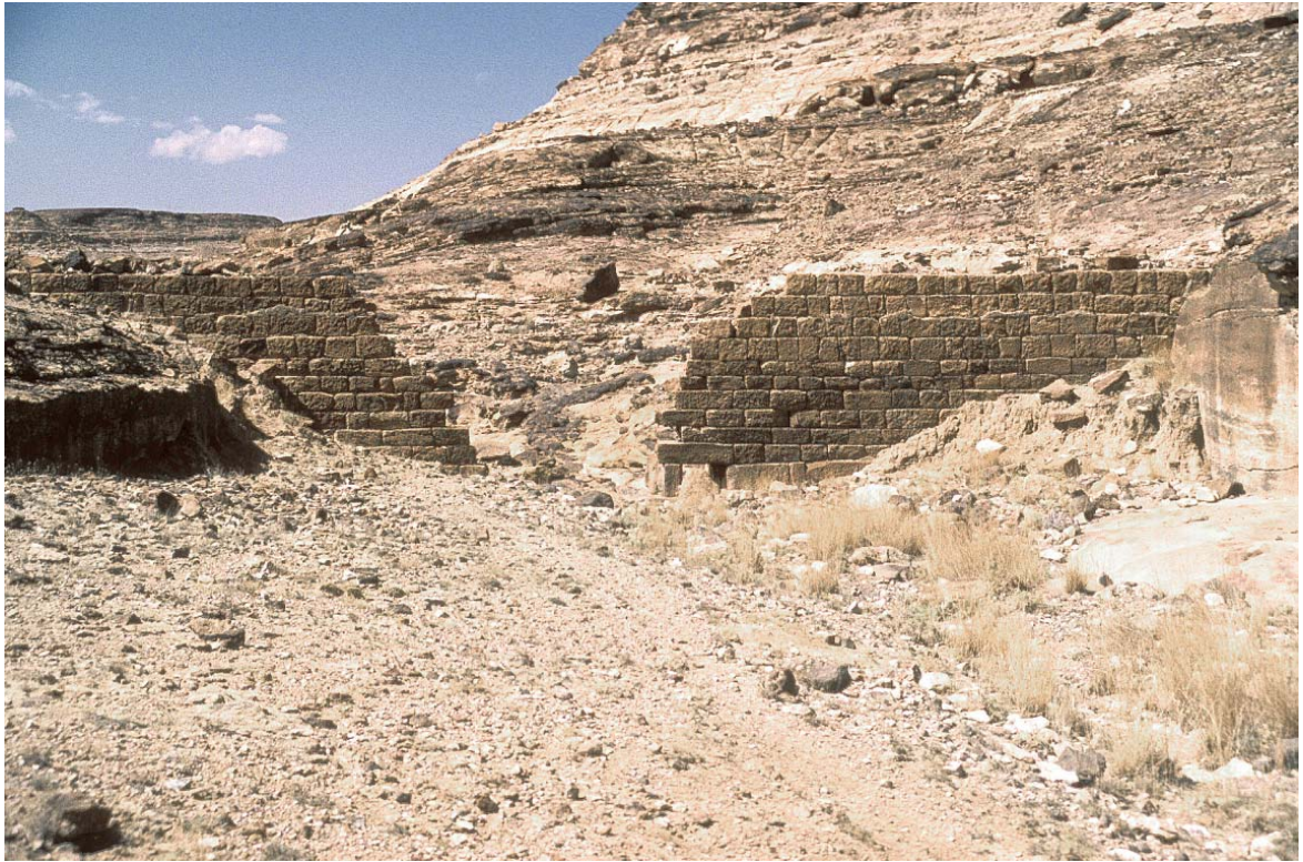
Abb. 18. Wadi Gailan, einzügiger Steindamm (Foto: H. Siewert).
