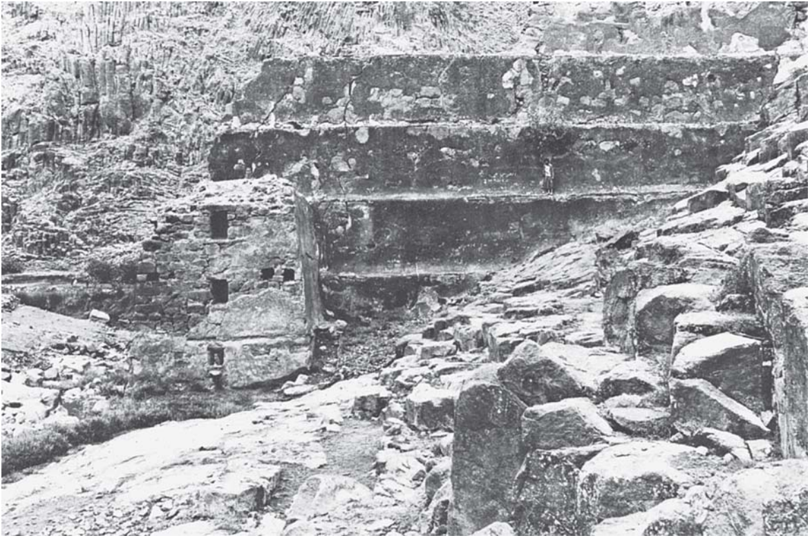
Abb. 22. Wadi Asid, wasserseitiger Auslassschacht (Siewert 1979, Taf. 38b).
