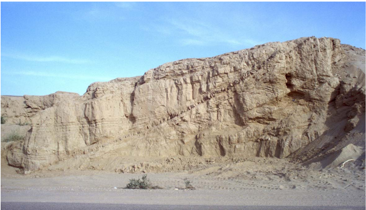
Abb. 10. Marib, Großer Damm, durch die Fluten angeschnittener Dammkörper mit Stickung und Stauraumsedimenten.
