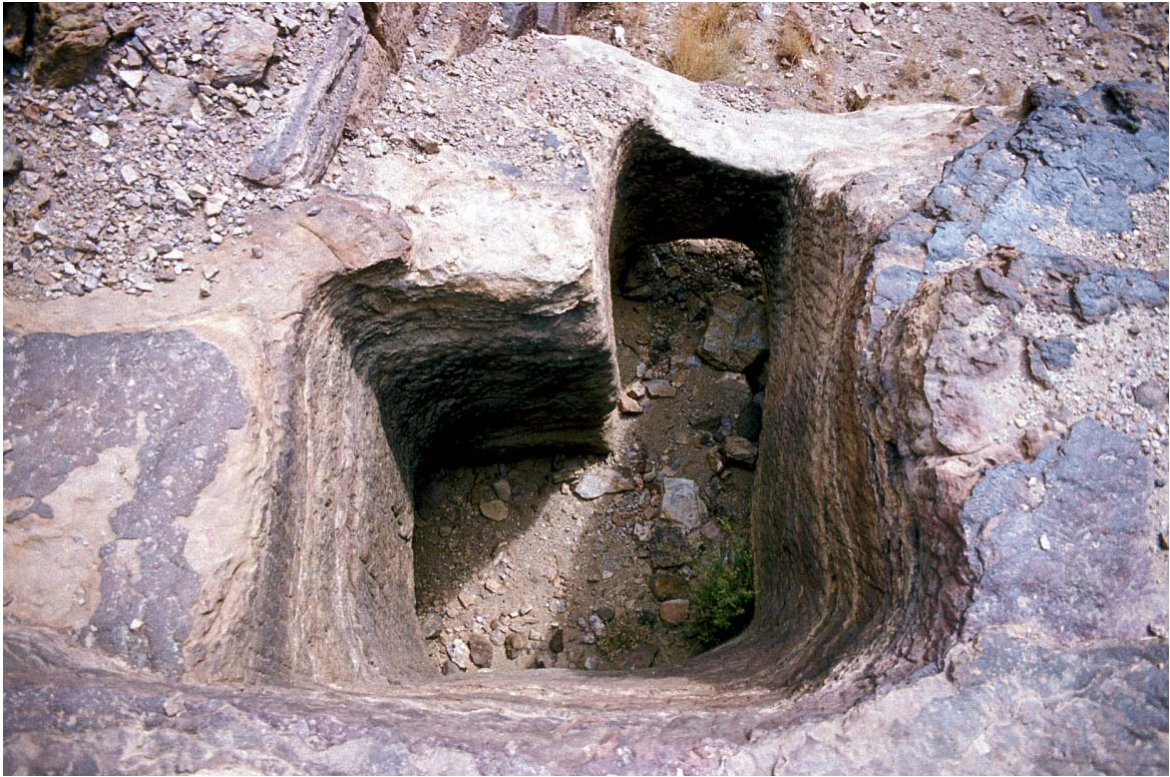
Abb. 19. Wadi Gailan, in den Fels gearbeiteter Fallschacht als Überlauf (Foto: H. Siewert).
