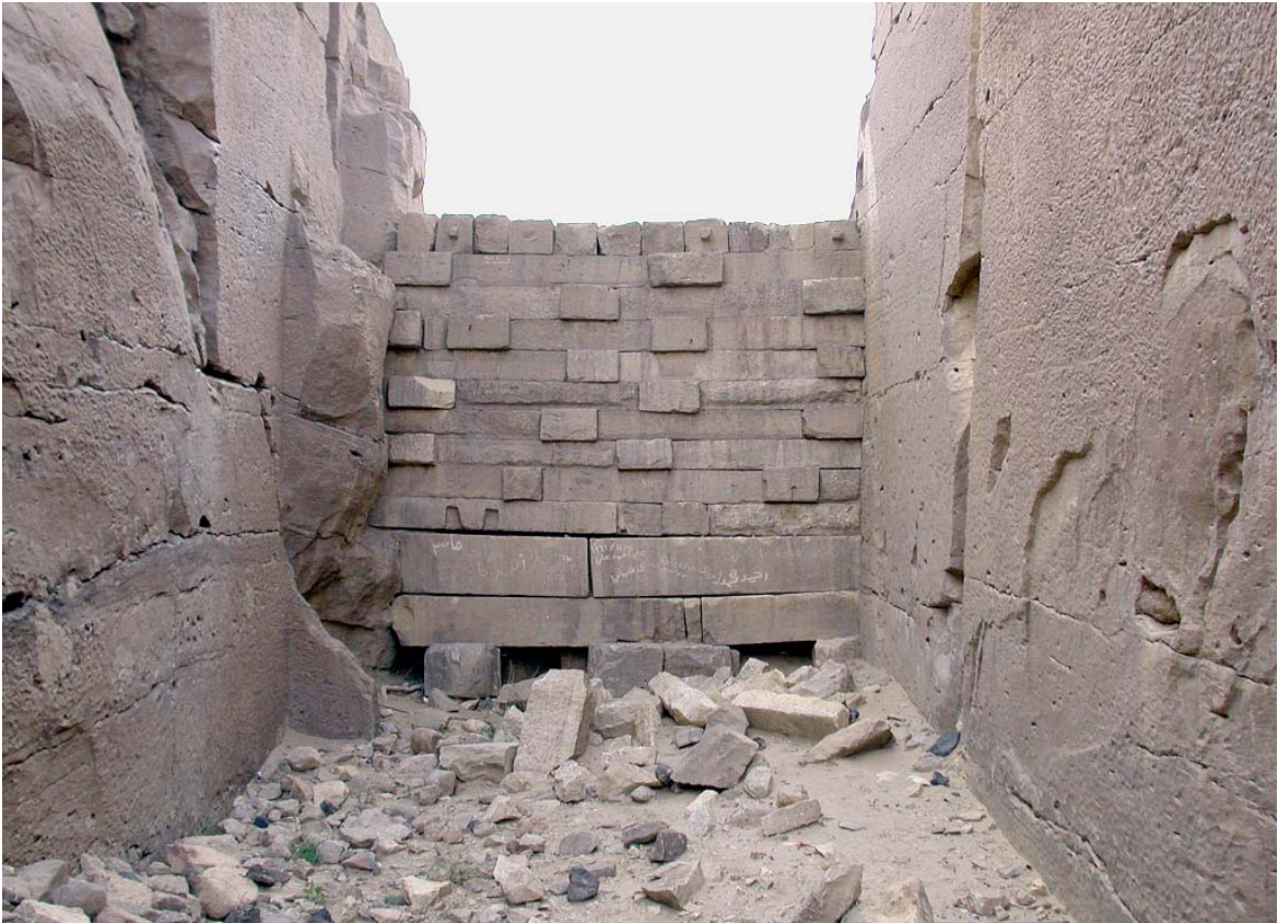
Abb. 9. Marib, Südbau des Großen Dammes, Felsdurchlass mit Schwelle.
