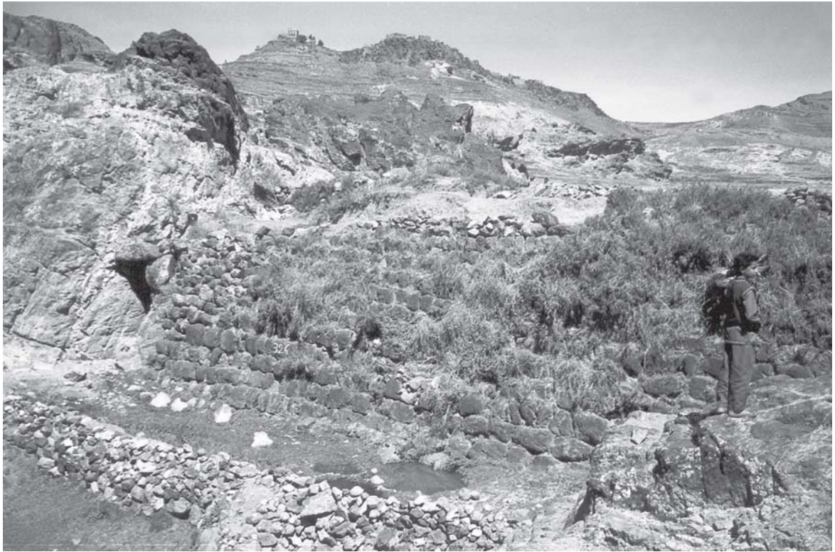
Abb. 16. Jemenitisches Hochland. Einzügiger Steindamm 1 km westlich von Zafar (Foto: P. Yule).
